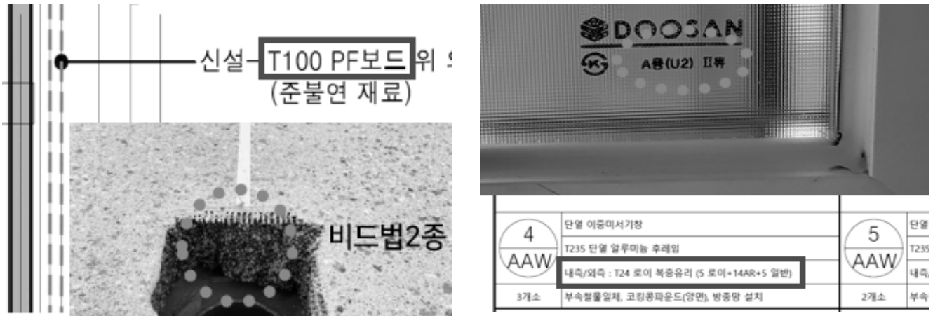
그림 11. 설계도서와 시공상태의 불일치(좌: 단열재, 우: 창호)
