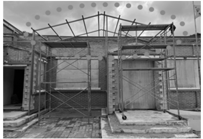
그림 13. 설계와 시공 내용의 차이 사례(좌: 프레임 2겹 설계, 우: 프레임 1겹 시공(중간단계))
