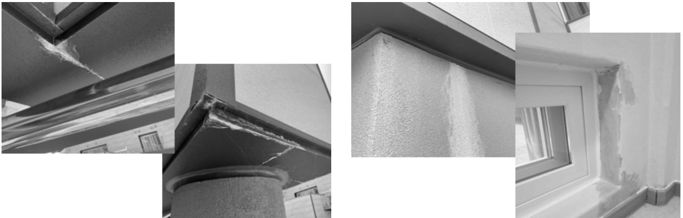
그림 12. 오시공에 의한 하자 발생(좌: 마감재오염 및 부식, 우: 누수 발생)
